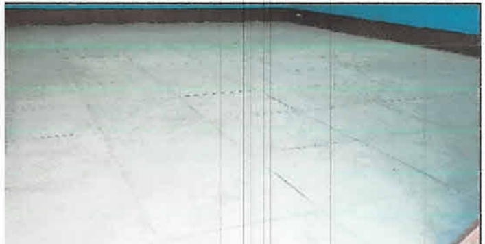
Foto 4: Módulo 2 Se ha finalizado exitosamente la colocación de piso cerámico en el salón de clases. Favoreciendo con ello a los estudiantes para que permanezcan en un lugar limpio y libre de polvo y tierra.
