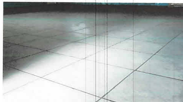
Foto 2: Módulo 3 colocación de piso cerámico concluido exitosamente.
