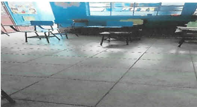
Foto 3: Módulo 3 Se ha culminado con la colocación del piso cerámico en el salón de clases y ya se ha iniciado su uso dejando ver que el proyecto fue de gran beneficio para la población estudiantil.
