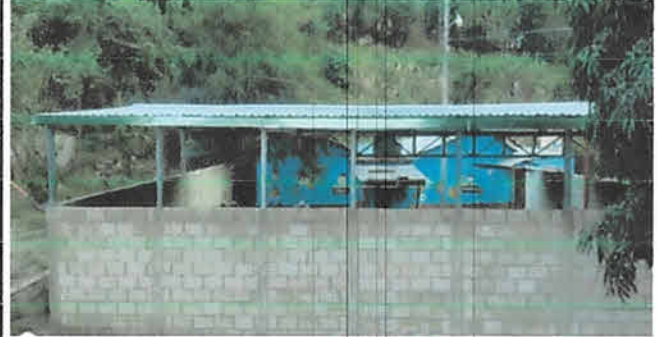
Foto 2: Módulo 1 finalización de la galera con la colocación de canales y bajas de agua, la cual permitirá que los estudiantes cuenten con un espacio para sus recreos y realización de actividades culturales en un
