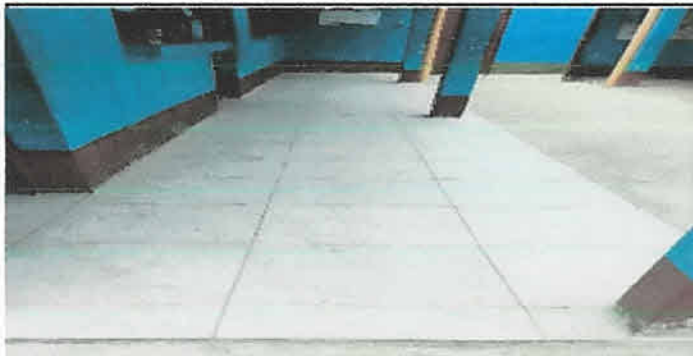
Foto 3: Módulo 2 colocación de piso cerámico en aulas y corredor esto permitira que los estudiantes cuenten con un mejor ambiente para recibir sus clases.
